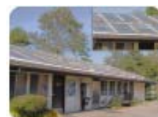
การติดตั้งแผงเซลล์สุริยะบนหลังคาบ้าน
